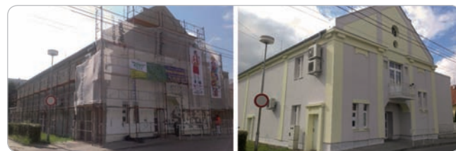
Obr. 1 Rekonštrukcia Kina Záhoran
