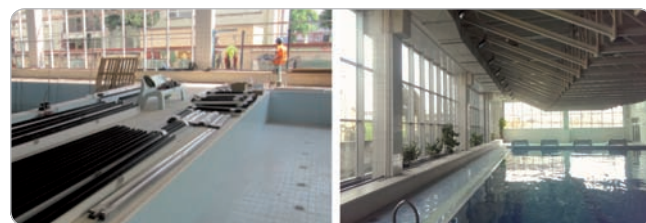
Obr. 2 Výmena presklenej steny v športovej hale Malina
