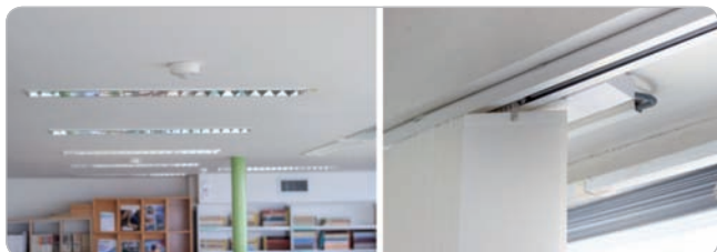
Obr. 4 Snímače a akčné členy regulácie osvetlenia: snímače prítomnosti osôb (vľavo), elektropohon vertikálnych žalúzií (vpravo)
