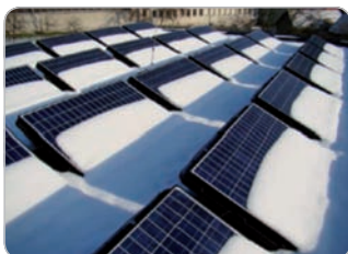
Obr. 11 Výkon fotovoltaických panelov na plochej streche objektu znižovala snehová pokrývka
