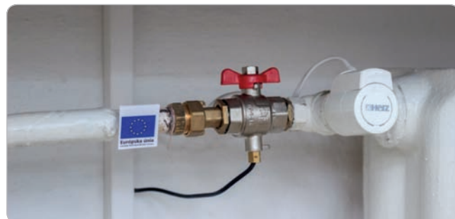
Obr. 3 Termoelektrický servopohon na ventile prírodného potrubia k vykurovaciemu telesu
