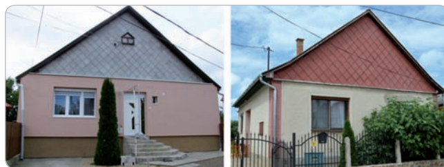
Obr. 2 Rodinné domy využité pri experimente (vľavo zateplený, vpravo v pôvodnom stave)
