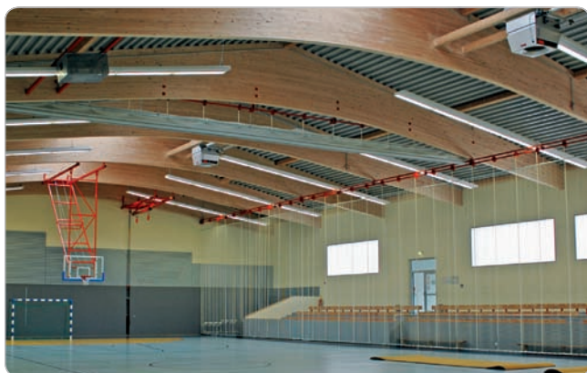
Obr. 1 Športová hala vykurovaná a vetraná decentralnými jednotkami (Goldbach, Thüringen)
